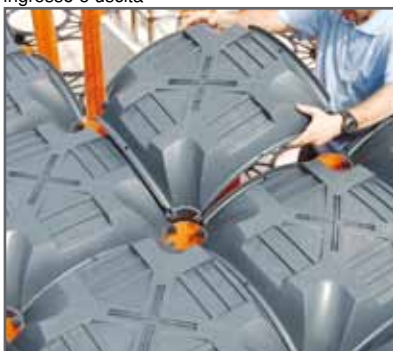
Posa del CASSERO NUOVO ELEVETOR®
