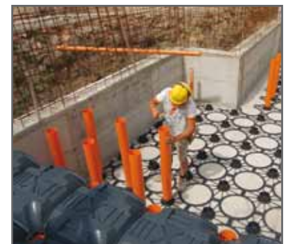
Posa dei tubi
