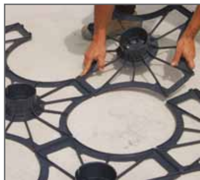
Posa della BASE NUOVO ELEVETOR®
