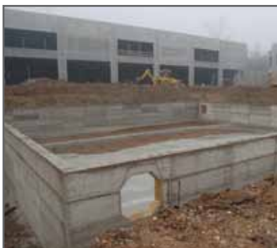
Preparazione della platea, dei muri perimetrali e predisposizione dei fori per le tubazioni di ingresso e uscita
